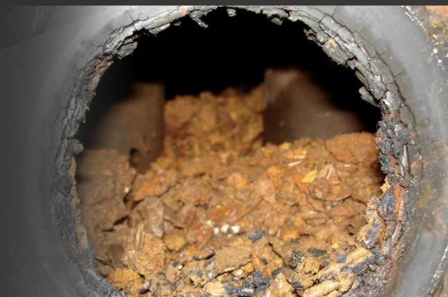
Les tubes d'évacuation et les échangeurs de chaleur interne au réservoir sont endommagés par le dépôt de calcaire dès la première heure de fonctionnement.
